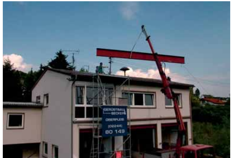
Der Stahlträger schwebt über dem Gerätehaus Uthweiler
